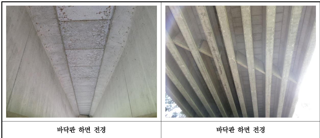
【사진 4.3.2】 바닥판하면 전경
