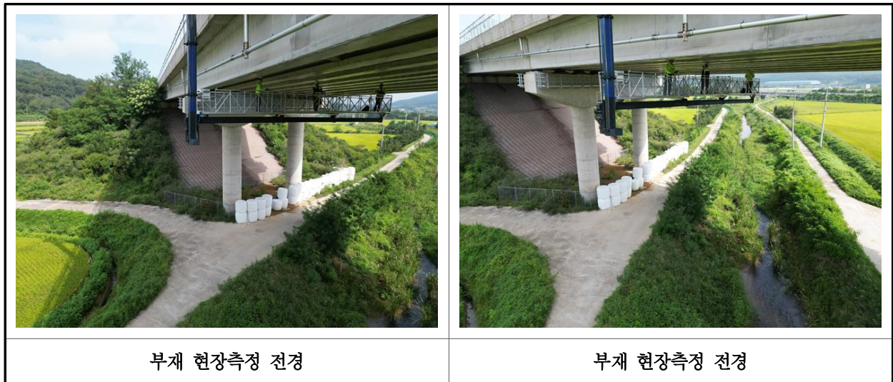
【사진 4.2.1】 부재 현장측정 전경
