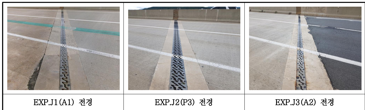
【사진 4.3.43】 신축이음장치 전경
