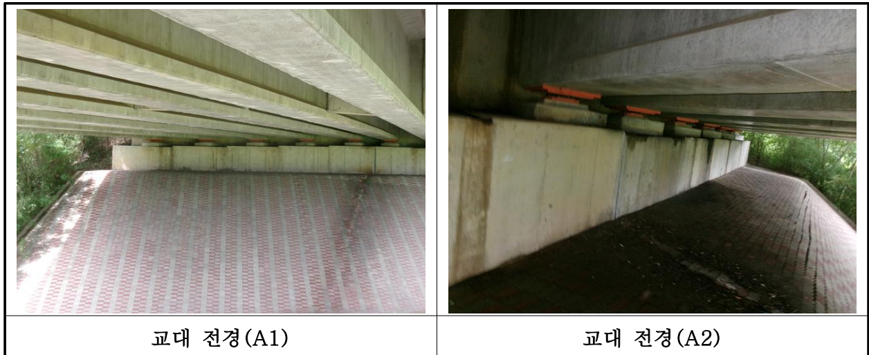
【사진 4.3.34】 교대 전경
