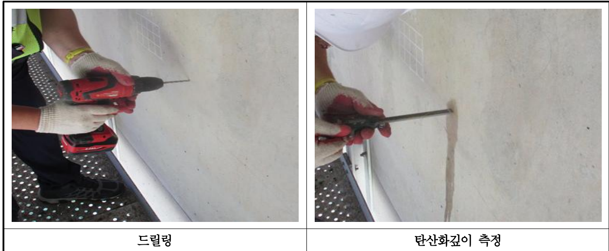
【사진 4.4.3】 탄산화 깊이 측정 현장사진
