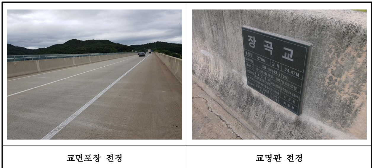
【사진 4.3.20】 교면포장 전경
