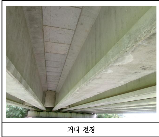
【사진 4.3.30】 거더 전경
